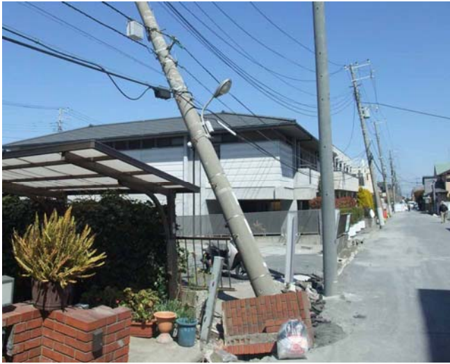
3 浦安市入船4丁目住宅地の電柱と塀の被害 液状化により宅地地盤が沈下したり、塀や電柱も傾く など広範囲に被害が出た。2011.3.17
