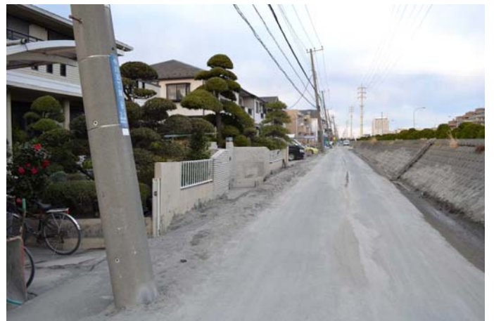
6 今川2丁目住宅地の被害 入船と有明、今川と高洲の間には1970年代まで 一時期海岸の防波堤であった構造物(右)が今も残る。 今川地区では住宅の多くが1m近く地盤沈下したり、 大きく傾いたり大きな被害を出した。2011.3.27
